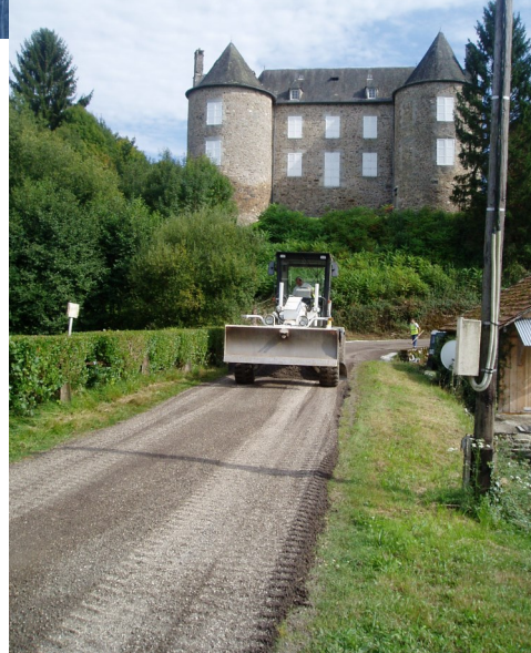
Travaux de voirie à Blanchefort
