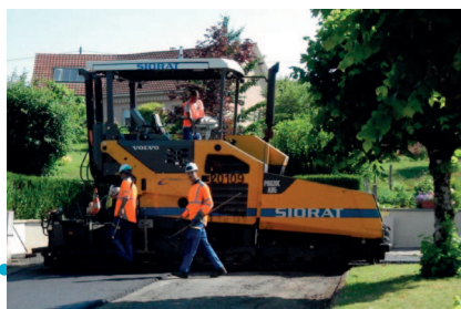
Travaux « impasse des Prunus »
