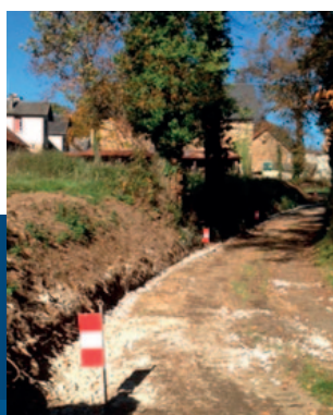
Réfection du chemin rural de la Buge Basse au Bois de Bellefond
