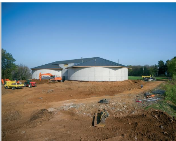
Réservoirs au Puy des Ferrières Photo prise par Franck BARRAT-ARNAL
