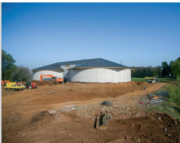
Réservoirs au Puy des Ferrières Photo prise par Franck BARRAT-ARNAL
